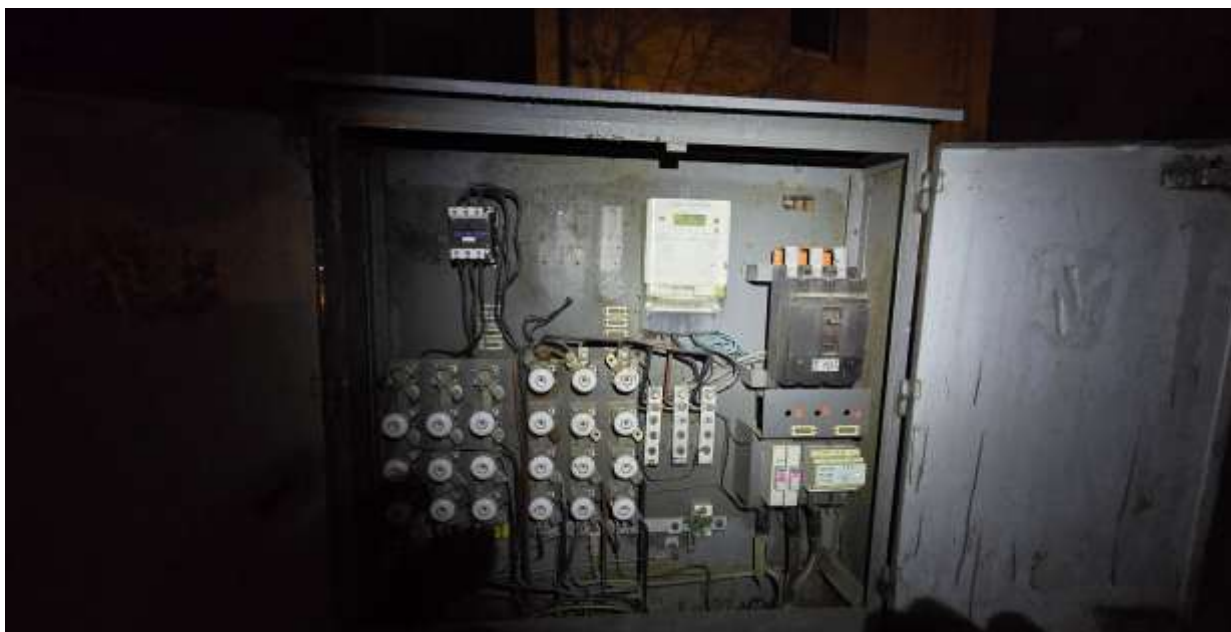
Od roku 2017 sa podarilo zrekonštruovať a úplne vymeniť 6 ks rozvádzačov
