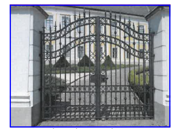
NOVÁ BRÁNA - KOVAČSKÁ OCEĽ - PRE REALIZÁCIU JE POTREBNÉ VYHOTOVÍŤ DIELENSKÚ DOKUMENTÁCIU UMELECKÝM KOVAČOM - PREKONZULTOVAŤ S KPÚ!
