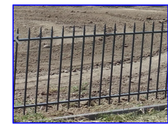
NOVÁ PLOTOVÁ VÝPLŇ - KOVAČSKÁ OCEĽ - PRE REALIZÁCIU JE POTREBNÉ VYHOTOVÍŤ DIELENSKÚ DOKUMENTÁCIU UMELECKÝM KOVAČOM - NÁVRH PREKONZULTOVAŤ S KPÚ!
